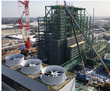
米子バイオマス発電所 (建設状況)
