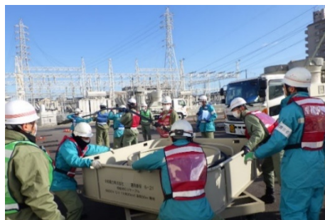
接続用ケーブルの設置作業
