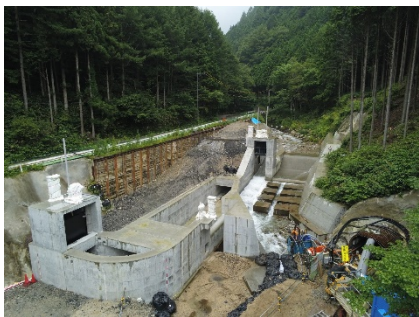
清内路水力発電所 (建設状況)
