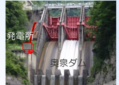
工事中の新奥泉水力発電所
