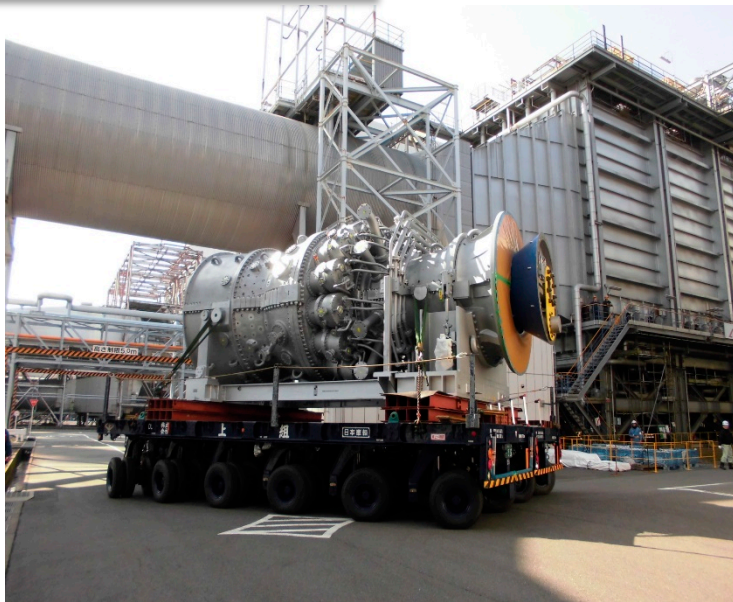
ガスタービンの発電所構内輸送
