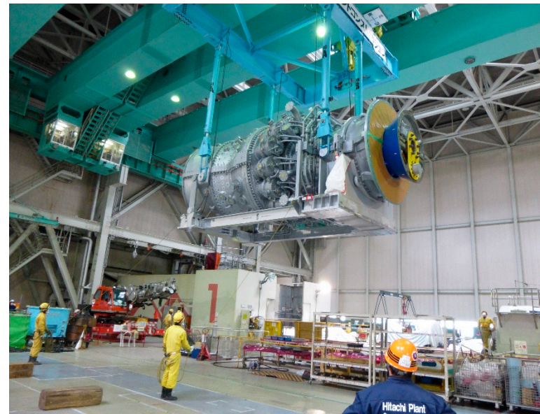
新型ガスタービンの据付
