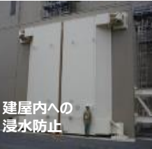
建屋大物搬入口（耐圧性・防水性強化）
