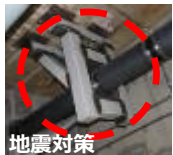
配管類サポート工事
