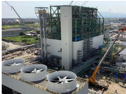
米子バイオマス発電所 (建設状況)
