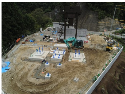
清内路水力発電所 (建設状況)
