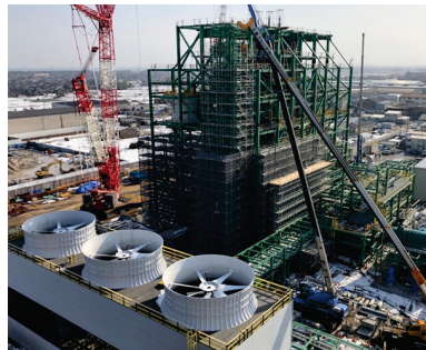
米子バイオマス発電所 (建設状況)
