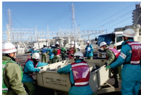
接続用ケーブルの設置作業
