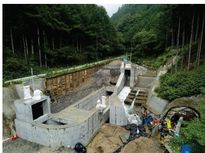
清内路水力発電所 (建設状況)
