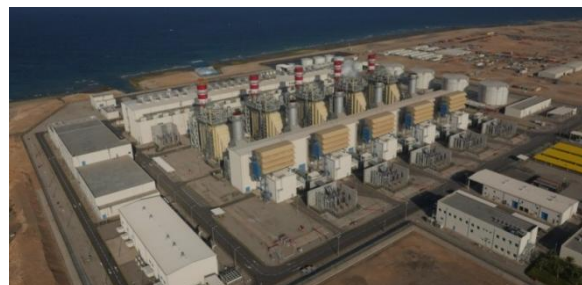
オマーン国・ガス火力IPP事業（スール火力発電所）
