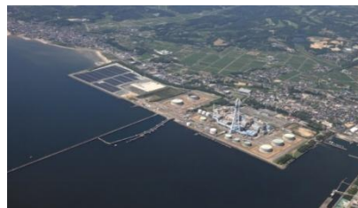
現状の武豊火力発電所
