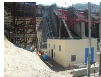
工事中的の新申原水力発電所
