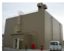
緊急時海水取水設備
