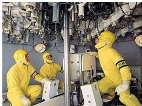
原子炉下部での制御棒駆動機構の 保守訓練
