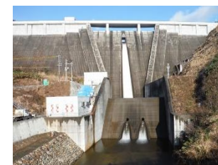
工事中の丹生川水力発電所
