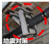
配管類サポート工事
