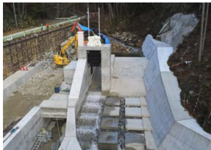
清内路水力発電所 (建設中)
