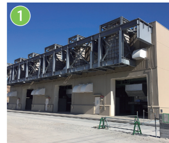
ガスタービン発電機建屋
