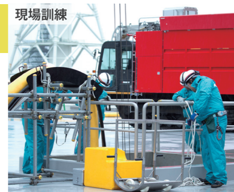
可搬型設備の操作
