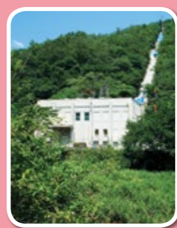
▲ 明知川発電所(上部図解C) ※水圧鉄管の取替工事中の発電所
