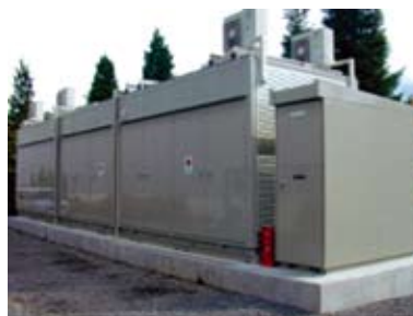
高圧大容量電気二重層キャパシタ式 無停電電源装置
