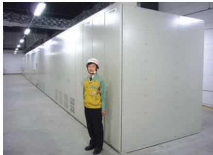
高圧大容量電気二重層キャパシタ式瞬低補償装置 (10,000kVA 1秒補償)
