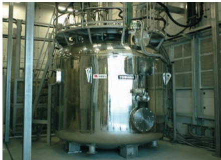
SMES (10,000kW 1秒間補償)装置 の実証試験
