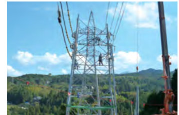
▲送電鉄塔上での作業
