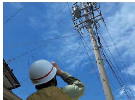
◀ 配電設備の巡視
