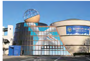
新エネルギーホール
