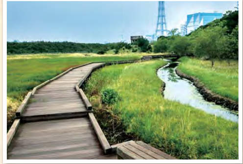
▲碧南火力発電所「エコパーク」(愛知県碧南市)の循環水路
