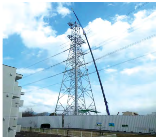
▲送電鉄塔の組立工事
