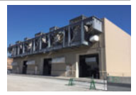
緊急時ガスタービン発電機(建屋)
