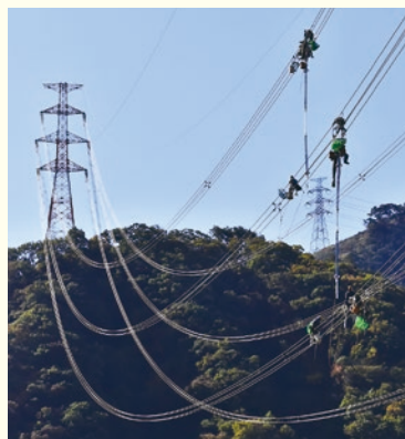
▲ 相間スペース取り付け工事の様子
