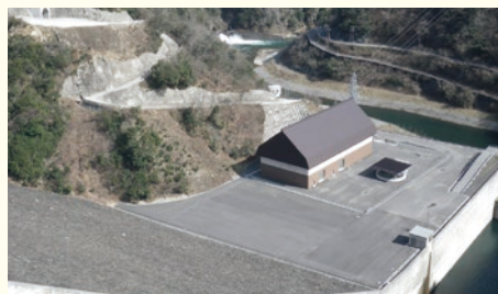
▲ 徳山水力発電所
