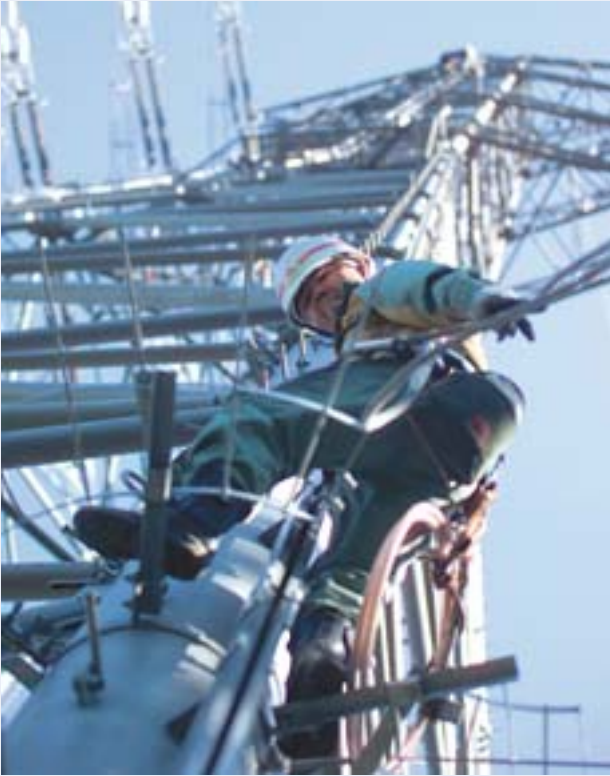
鉄塔に昇っての品質検査
