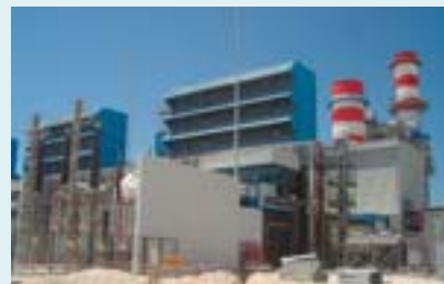
2006年5月に一部営業運転を開始したカタールの発電設備
