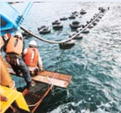
神島(三重県鳥羽市)の電力供給を、離島発電から系統電力へ切り替えるため海底ケーブルを8km敷設。2005年6月より送電開始。
