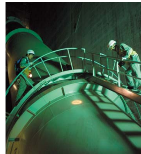
水力発電所で水圧鉄管の点検を行う従業員
