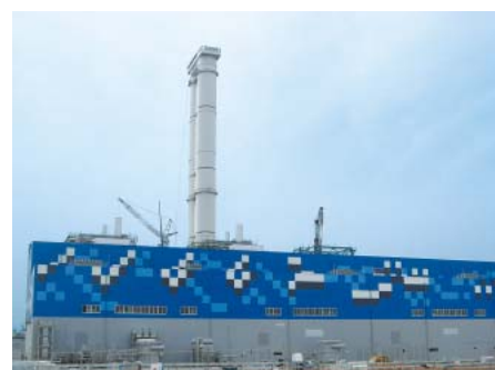
新名古屋火力発電所8号系列本館
