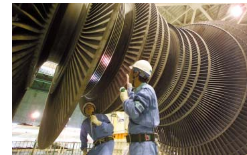
浜岡原子力発電所でのタービン組み立て作業
