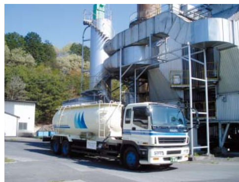
焼却場にシーキュラスを搬入する様子
