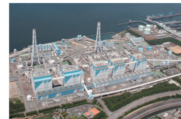
碧南火力発電所
