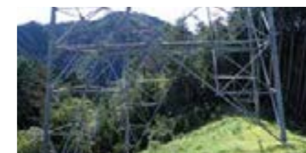
地域性に配慮した在来種のみで鉄塔下を緑化（確実な緑化を目指しモニタリング調査を実施中）
