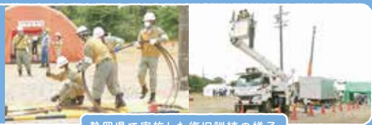
静岡県で実施した復旧訓練の様子
