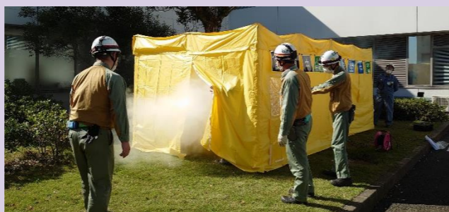
仮設テントを設置
