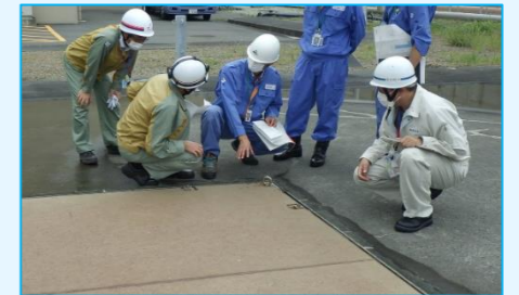
3号試掘坑の整備状況を確認いただいている様子
