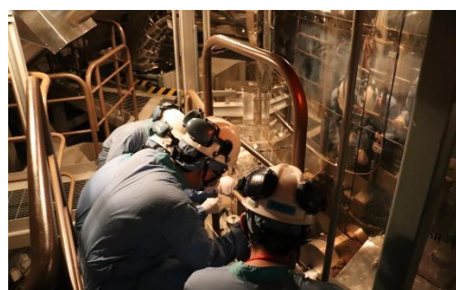
温度計の据付状況を確認いただいている様子
