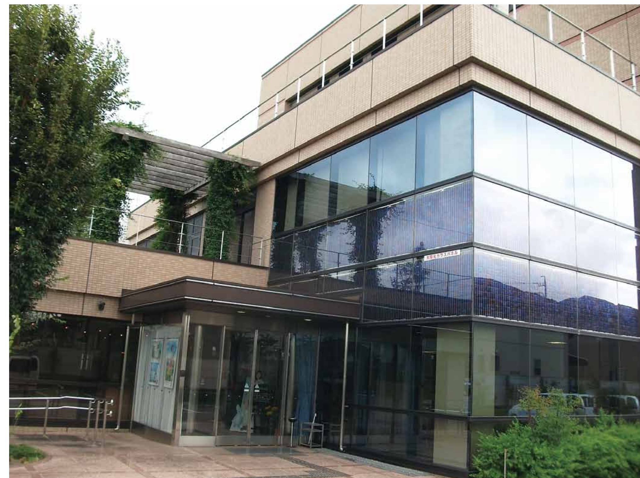
鈴鹿営業所 3(kW) 当社事業場としても珍しい窓ガラス垂直設置(90度)
