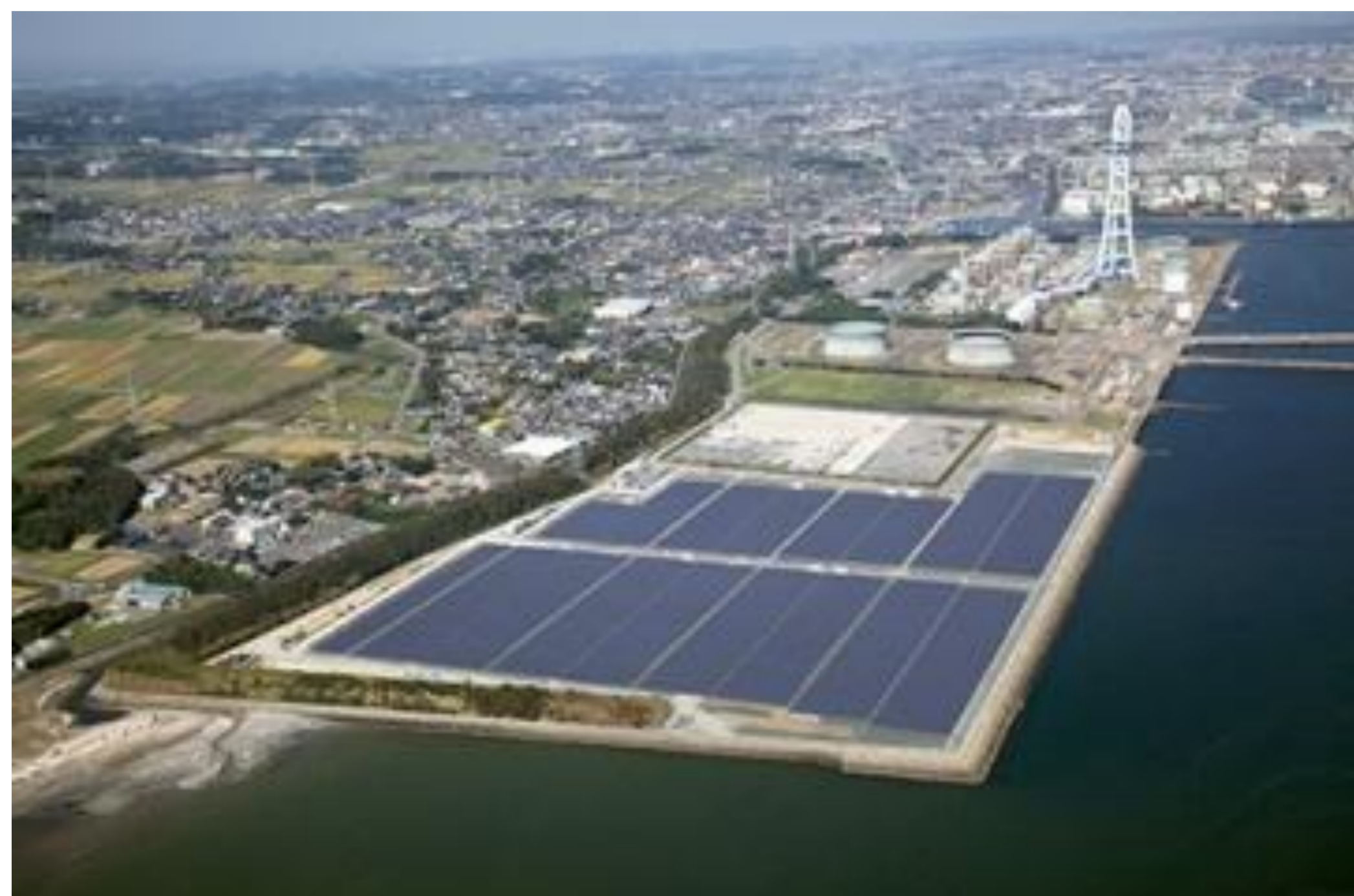
太陽光発電設備
