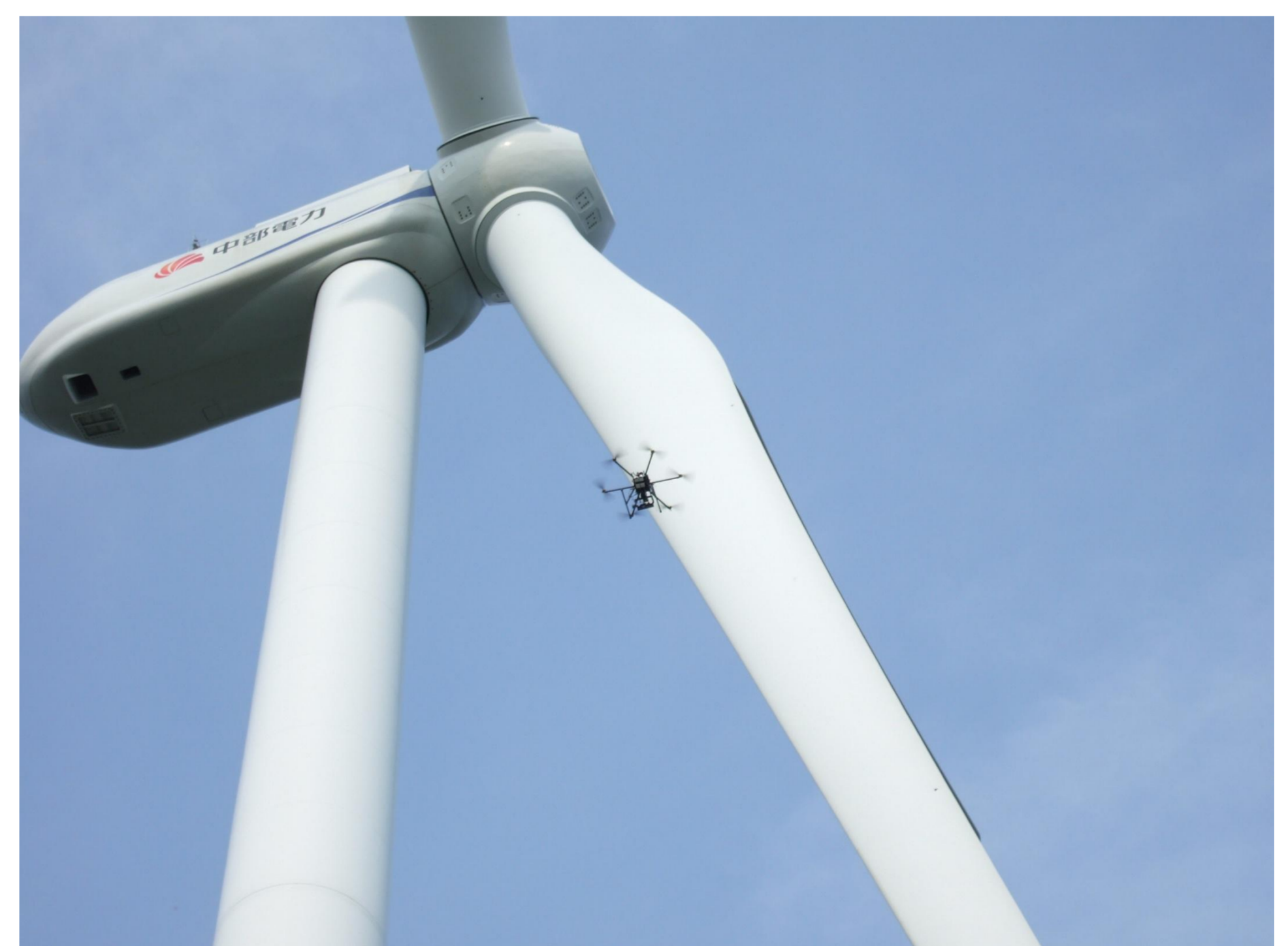
風力発電所への適用
