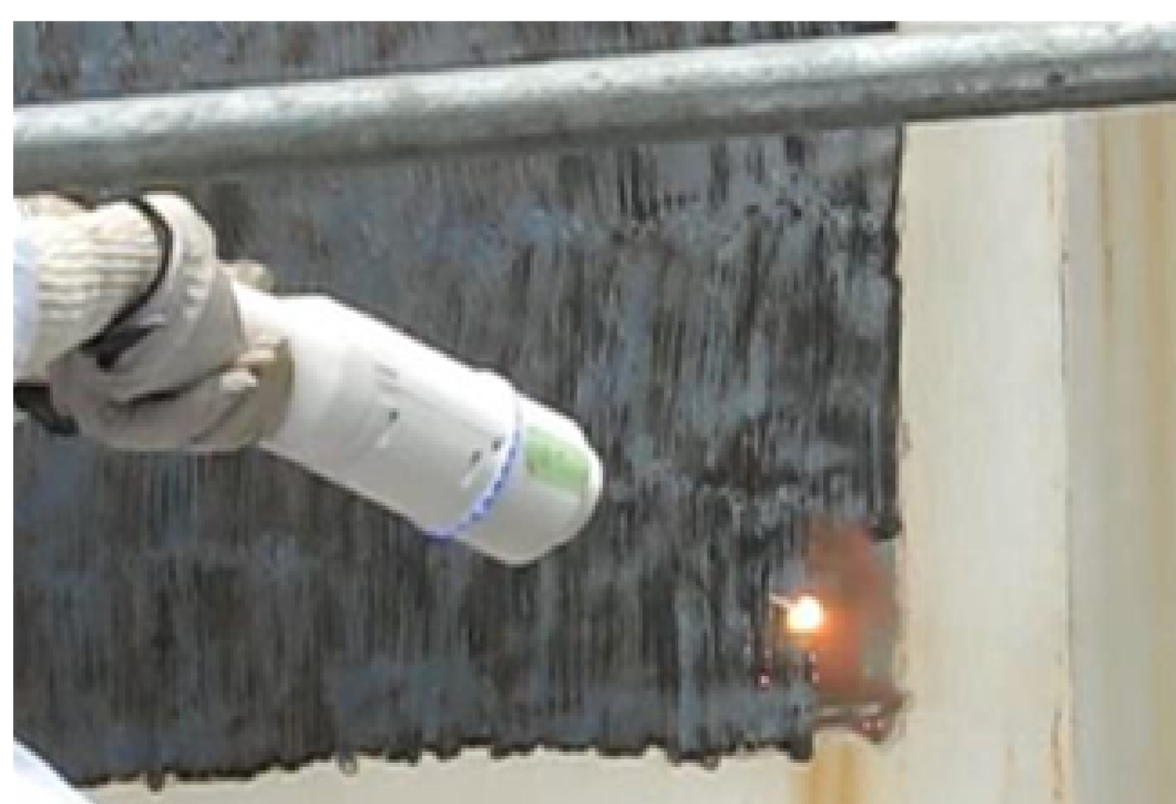
除染技術のベースとした「ポータブルレーザー塗膜除去装置」
