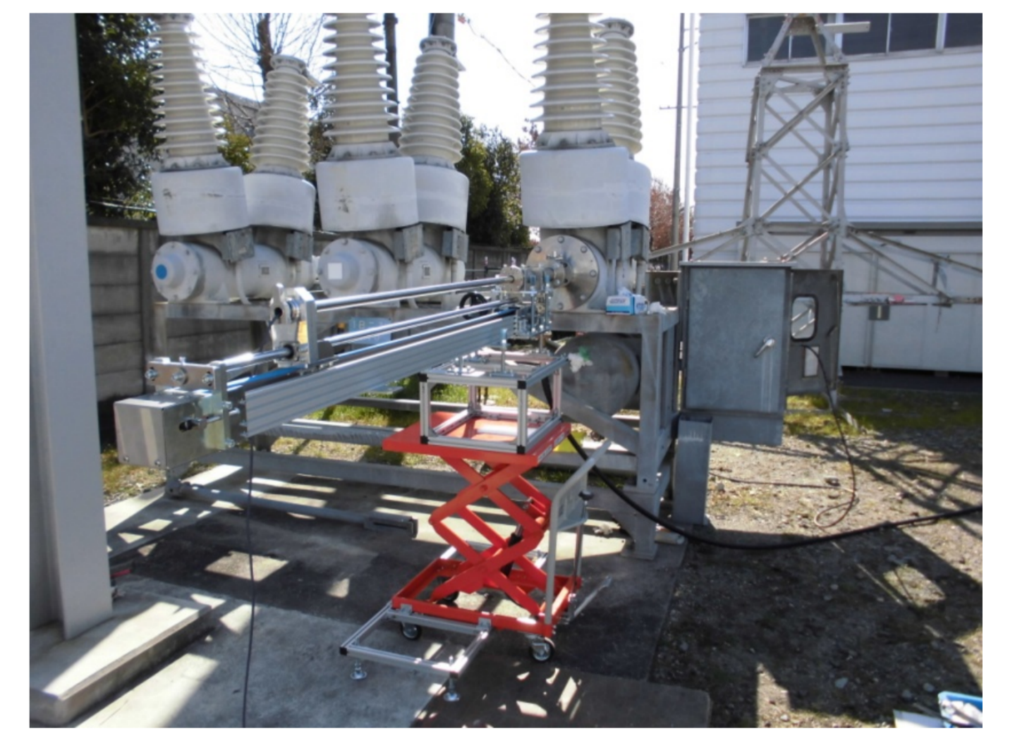
カメラ挿入作業の様子
