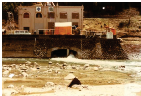
減勢工からの流出状況
