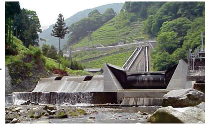
ゴム堰付 えん堤
