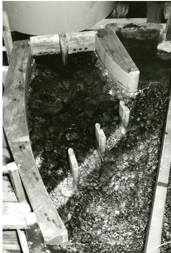
矢作第一水力発電所放水口 昭和43年
