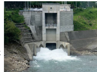
完成した 放水口
