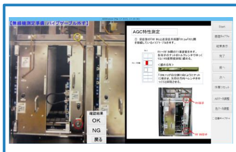
屋内機器点検の動作イメージ
