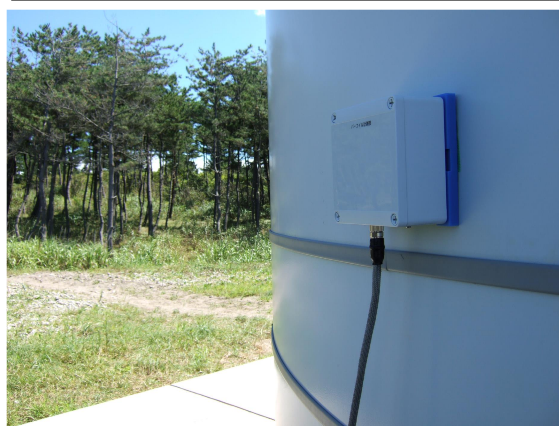
風車タワーへの装置取付状況
