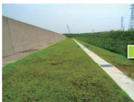
2013/8/8 施工後約1カ月目
