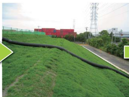
2017/7/14 施工後約3カ月
