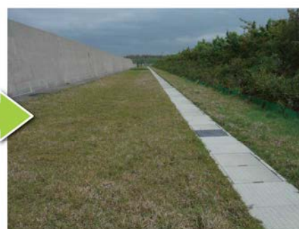
2018/5/17 施工後約5年目
