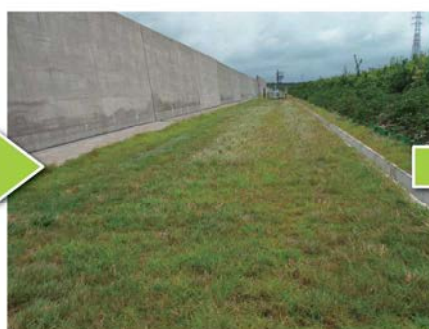
2016/8/17 施工後約3年目
