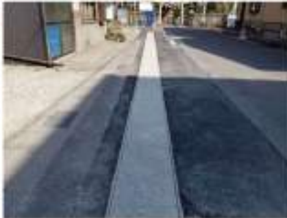
復旧完了(As 舗装)
