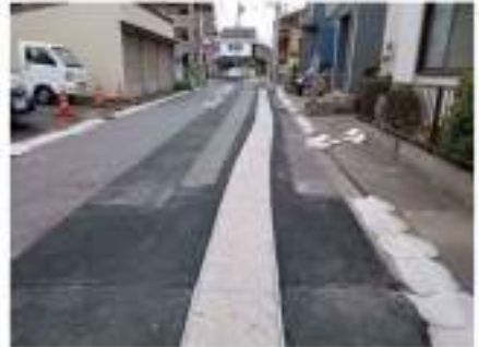
据付完了(As 舗装) (曲線部施工状況)
