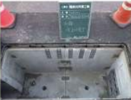
内面仕上げ完了
