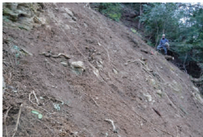
対策前の地表面の様子
