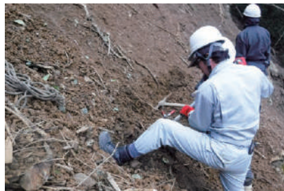
鋼製シガラによる対策
