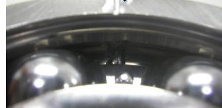
異常ベアリング 外輪傷あり
