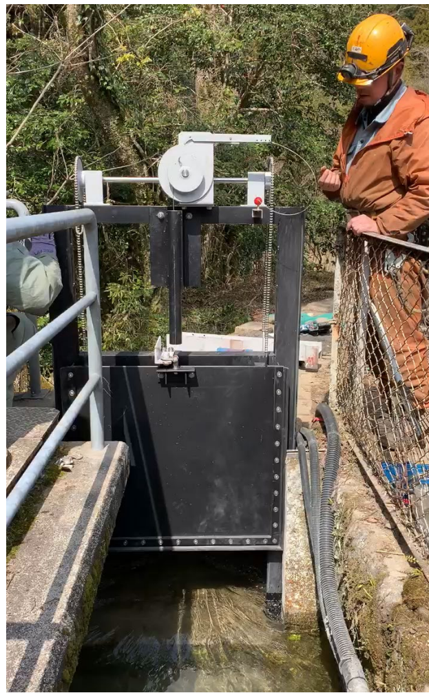
設置後 (上流側より)
