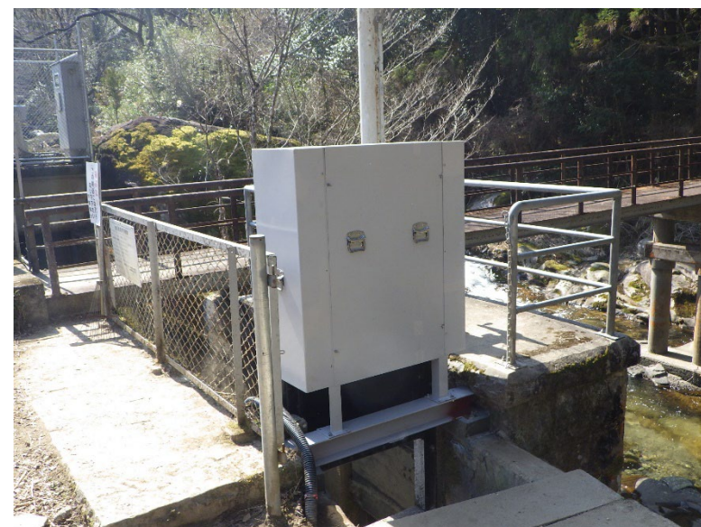
カバー設置状況 (下流側より)
