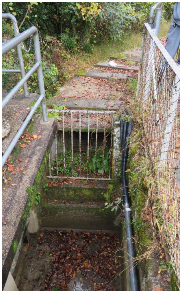
設置前 (上流側より)
