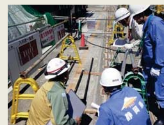
4号機取水槽地盤改良工事点検の様子
