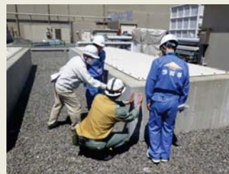
地下配管ダクト点検口・入口扉等閉止（津波対策）点検の様子
