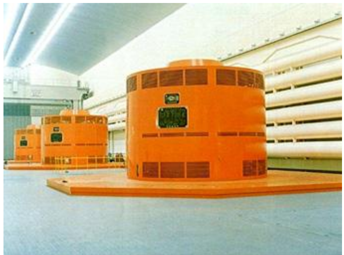
奥矢作第二発電所
