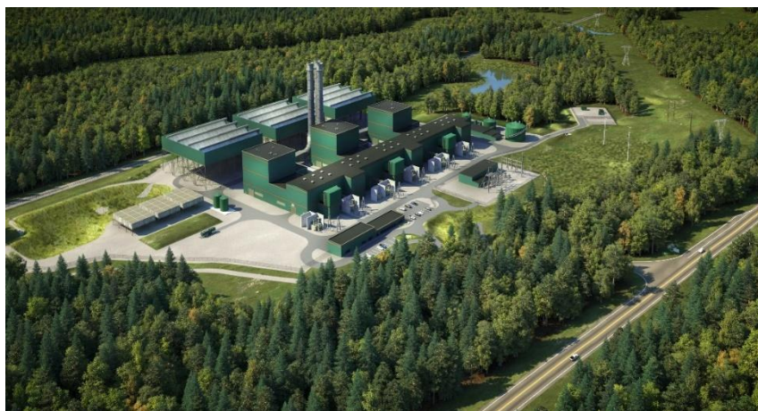
クリケット・バレーガス火力発電所 イメージ図
