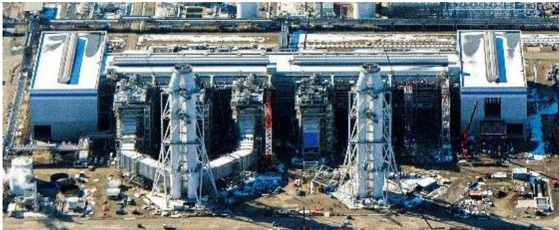
建設工事中の西名古屋火力発電所
