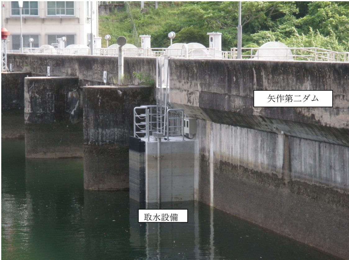
矢作第二ダム上流側
