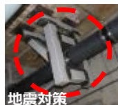
地震対策 配管類サポート工事
