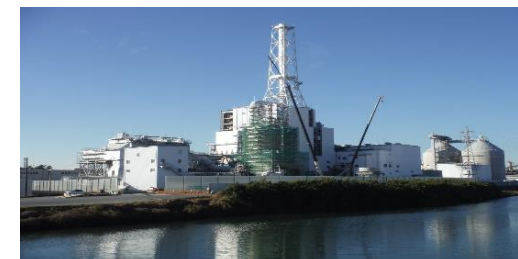
鈴川エネルギーセンターが建設中の石炭火力発電所の様子
