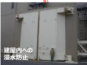
敷地内への 浸水防止 防波壁 <高さ：海拔22m>
