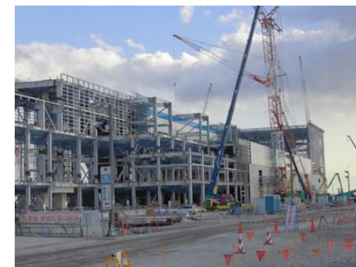
建設工事中西名古屋火力発電所
