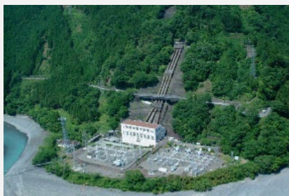
【大井川水力発電所】
