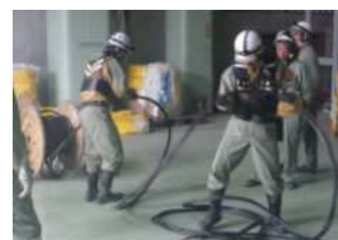
電源設備 ケーブル敷設・接続訓練
