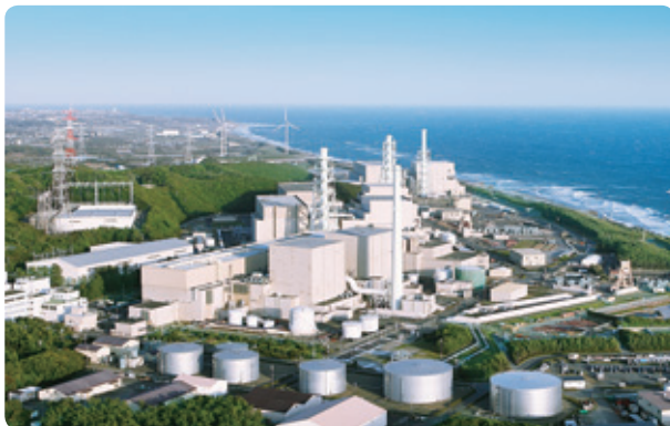
浜岡原子力発電所
