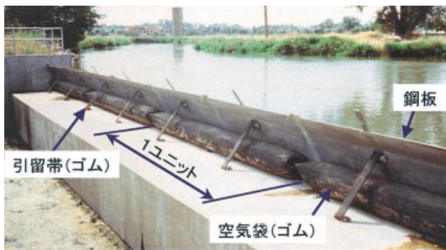
第1図 SR堰の設置状況(米国)
