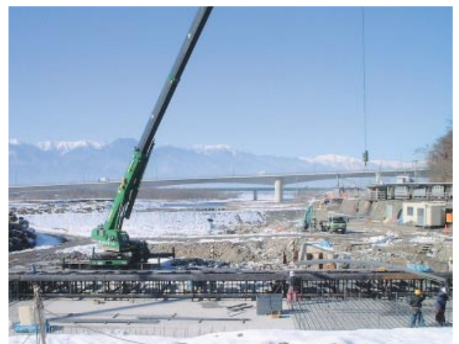
第7図 工事現場状況(平成15年1月現在)
