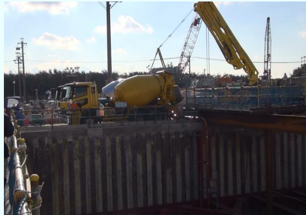
ポンプ室底部のコンクリート打設作業(3号機)
