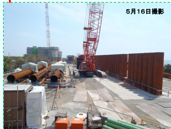
鋼管矢板の建て込み工事の様子
