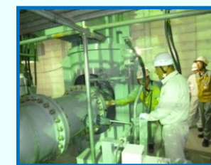
写真は緊急時海水取水設備の点検の様子
