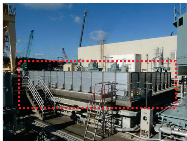
防水壁設置後
