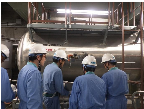
格納容器 pH 制御設備の設置工事 点検の様子
