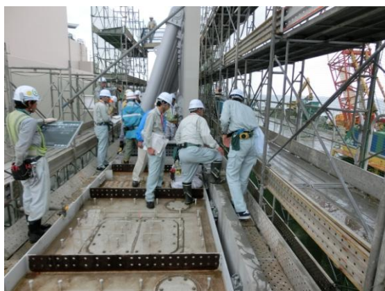
防波壁一般部点検の様子
