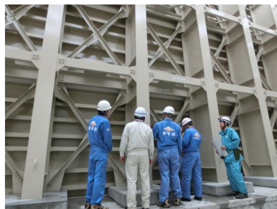
熱交換器建屋点検の様子
